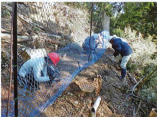
実習の様子（防護柵設置作業）
